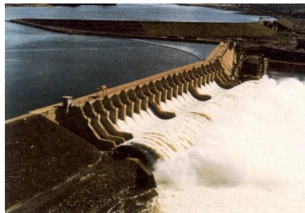
Figura 1 – Barragem de Tucuruí do tipo gravidade. (FONTE: http://www2.transportes.gov.br/bit/hidroviabarragens/tucuru.htm )
