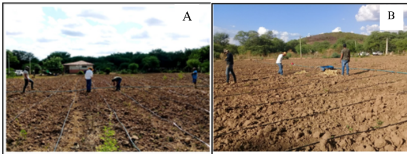
Figura 1. Instalação de sistema de irrigação (A), plantio de mudas de capiaçu (B) naVPR Ipê (Jati – CE).
