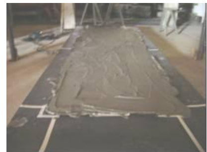
Figura 16 – Argamassa de assentamento.
