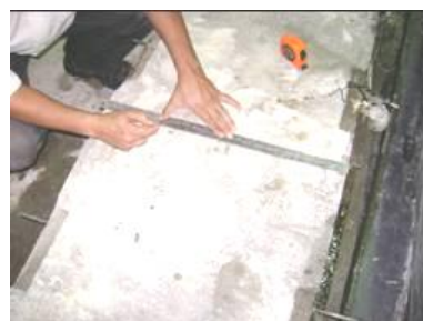
Figura 11 – Marcação da junta.
