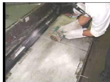
Figura 12 – Corte da junta.
