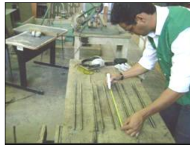
Figura 04 – Corte das barras.
