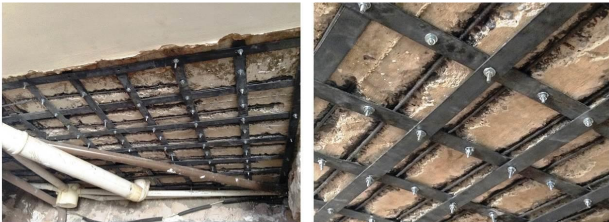
Figura 9 - Execução da recuperação da armadura da laje superior.
