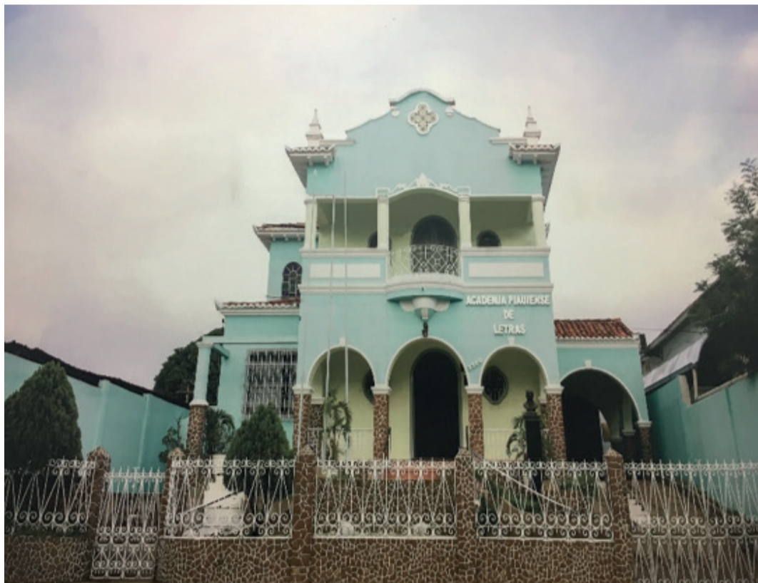
Figura 04: Fachada em tons de azul esverdeado. Fonte: (Autoras, 2017)
