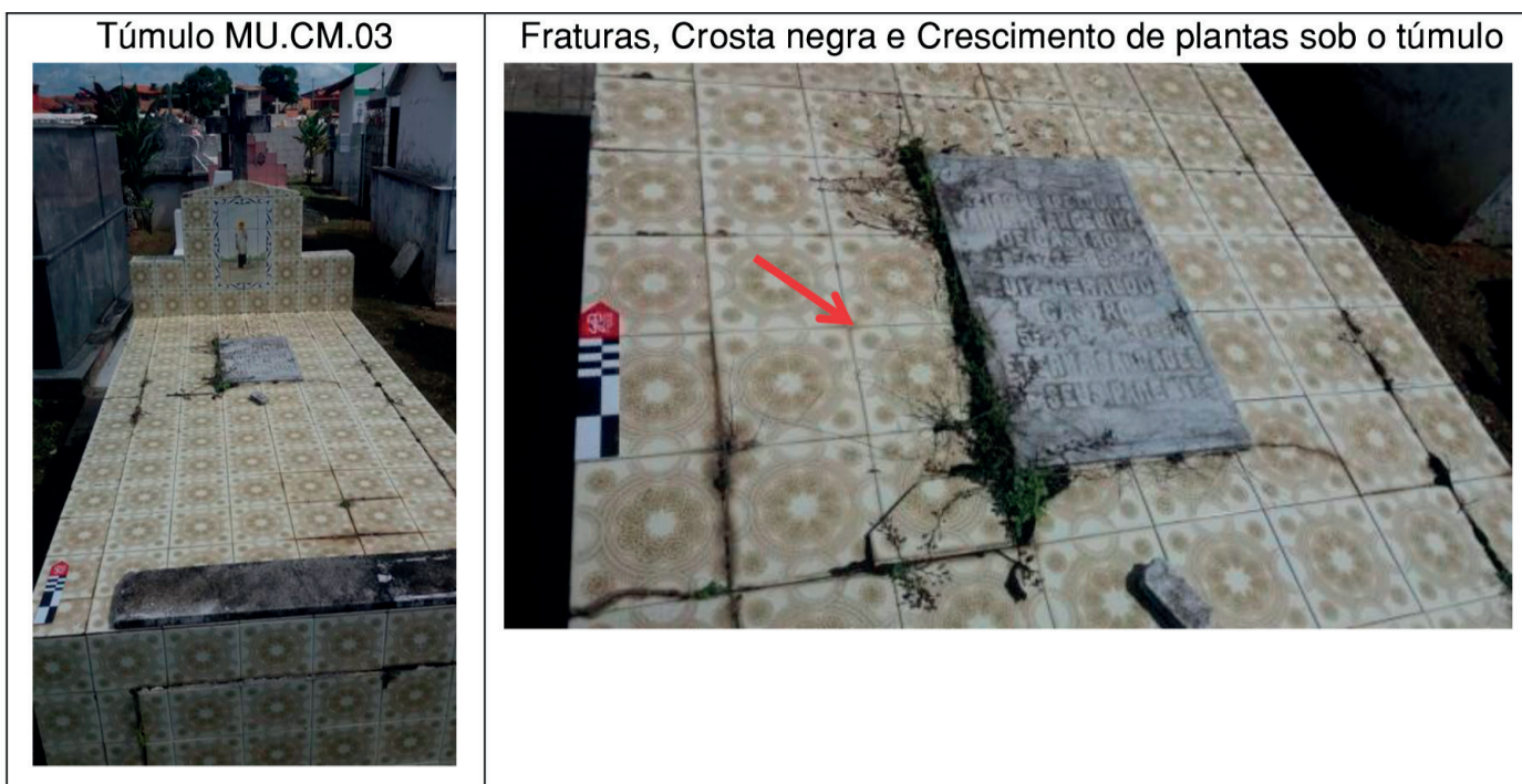
Quadro 3: Diagnóstico de alteração do Túmulo MU.CM.03
