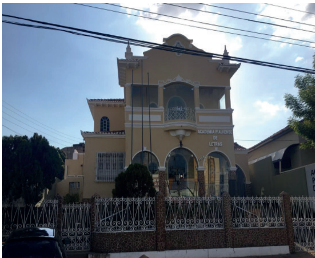
Figura 05: Fachada em tom amarelado. Fonte: (Autoras, 2019)
