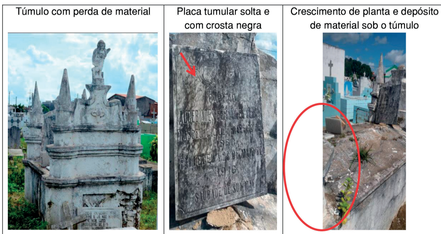
Quadro 4: Diagnóstico de alteração do Túmulo MU.CM.04
