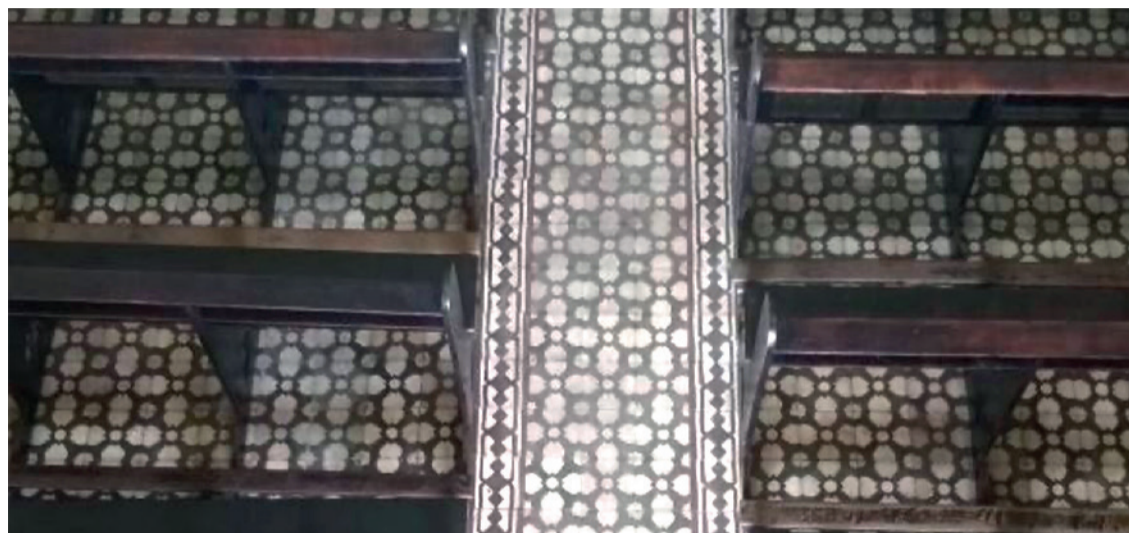
Figura 03 – Ladrilho hidráulico utilizado na Matriz, com destaque na nave central Fonte: Arquivo pessoal, 2019
