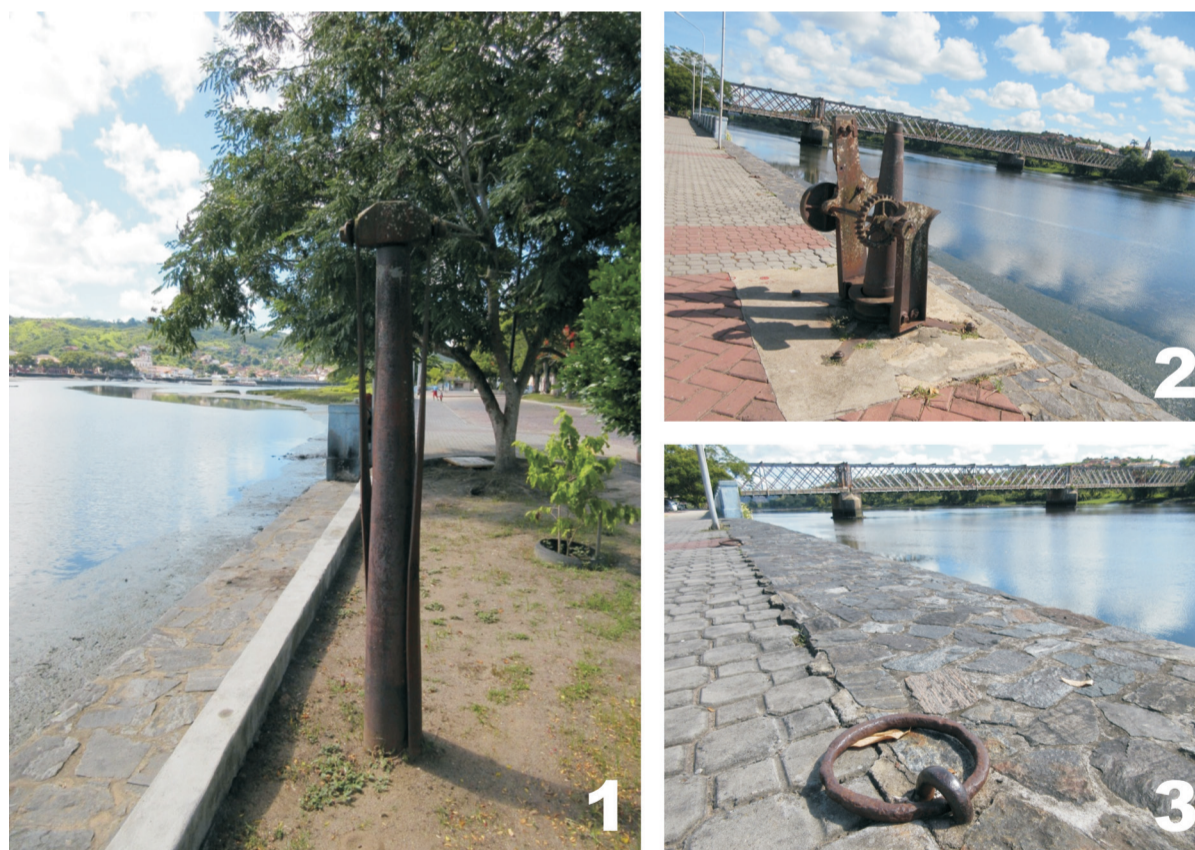
Figura 7: Estruturas remanescentes de amarração no cais de São Félix. Fonte: (Fabiana Comerlato, 2019).
