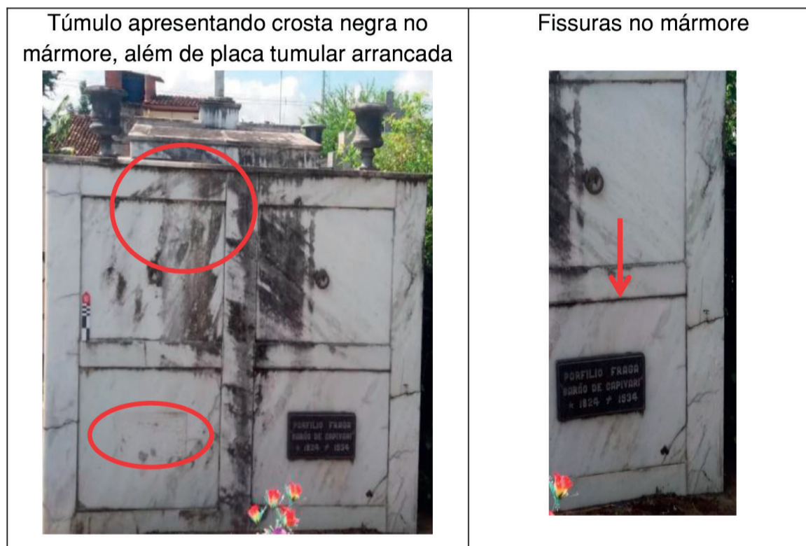
Quadro 6: Diagnóstico de alteração do Túmulo MU.CM.06
