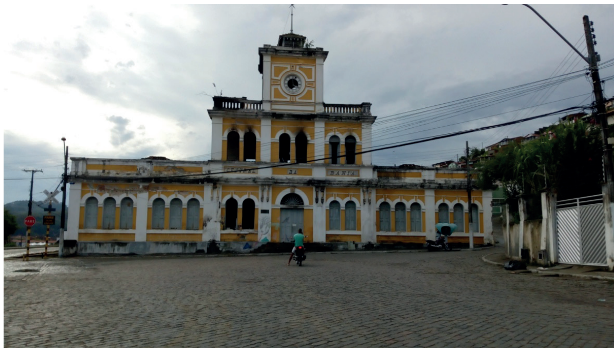
Figura 2: Fachada da Estação Ferroviária de São Félix. Fonte: (Fabiana Comerlato, 2017).
