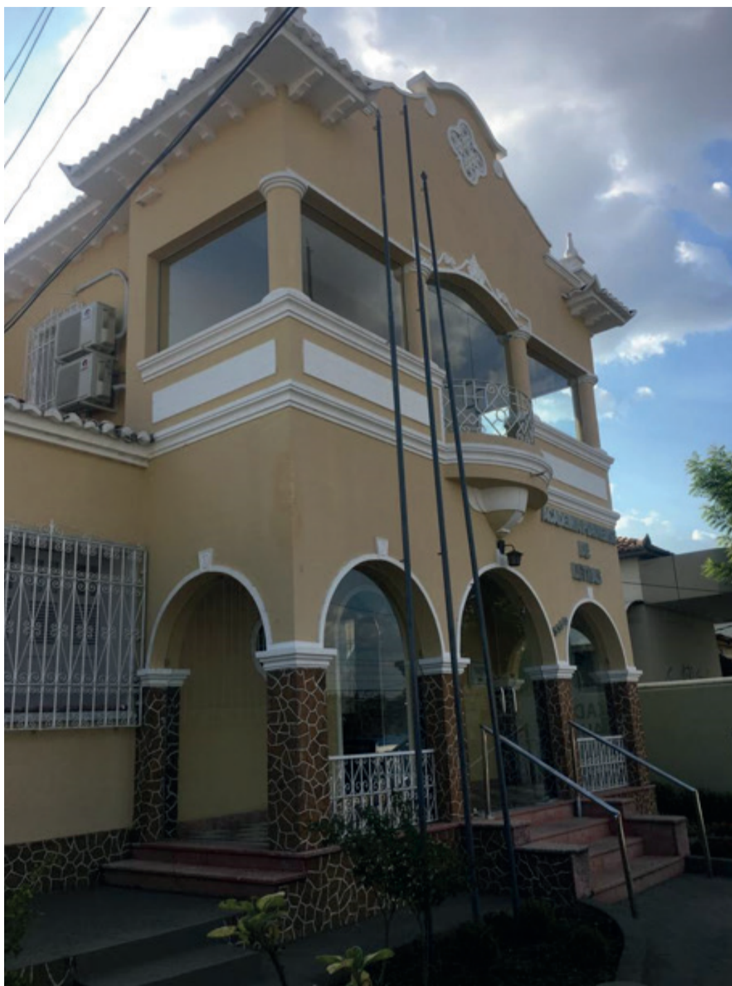
Figura 08: Fachada da edificação no ano de 2018. Fonte: (Autoras, 2018)
