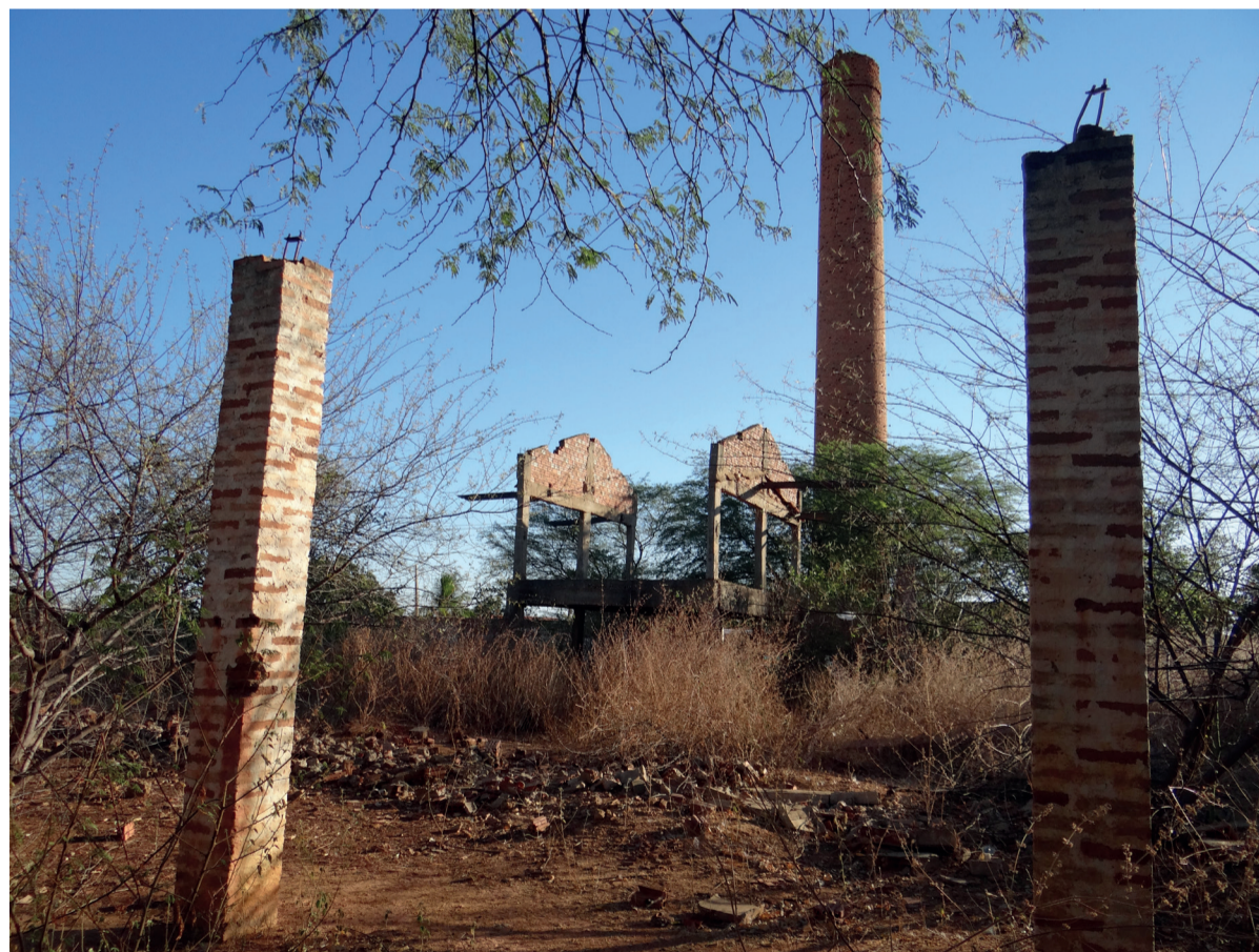
Figura 2: Imagens da chaminé e estruturas da Fábrica de Cerâmica Castanheiro Fonte: (RIBEIRO, 2018, p. 41)
