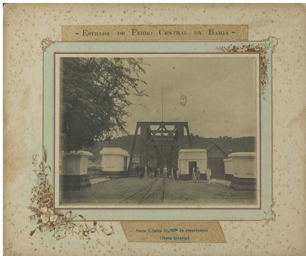
Figura 4: Ponte Dom Pedro II. Fonte: (SILVA, [19--]).
