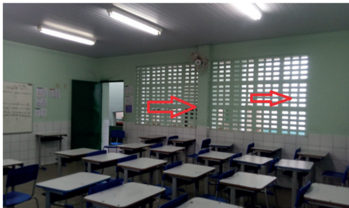
Figura 6: Cobogós na figura com indicação das setas acima, na Escola Gercílio de Castro Macêdo. Fonte: Autores.
