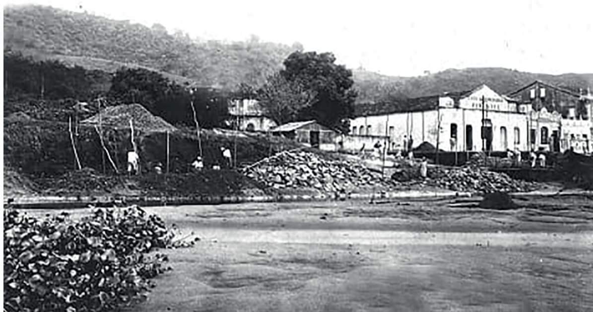
Figura 6. Construção da muralha do cais do porto de São Félix. Fonte: (Arquivo Público Municipal Dr. Júlio Ramos de Almeida).
