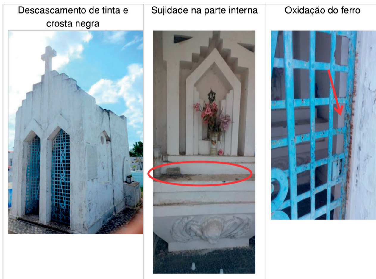
Quadro 2: Diagnóstico de alteração no Mausoléu MU.CM.02
