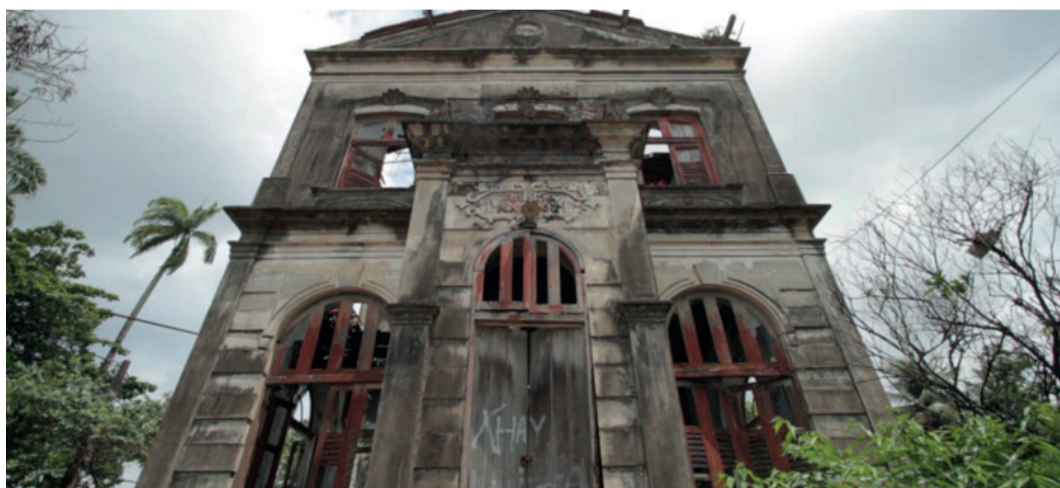
Figura 1: Fachada do Casarão 6 .
