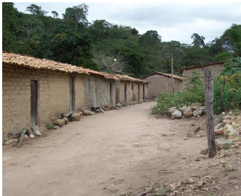
Foto 2 – Observação de estruturas Fonte: Próprio Autor (2023)
