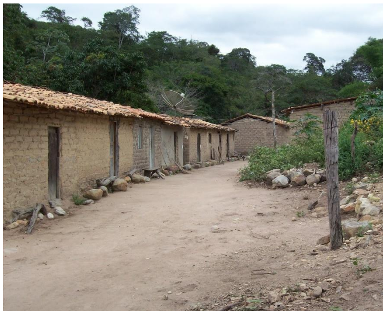
Foto 2 – Observação de estruturas Fonte: Próprio Autor (2023)
