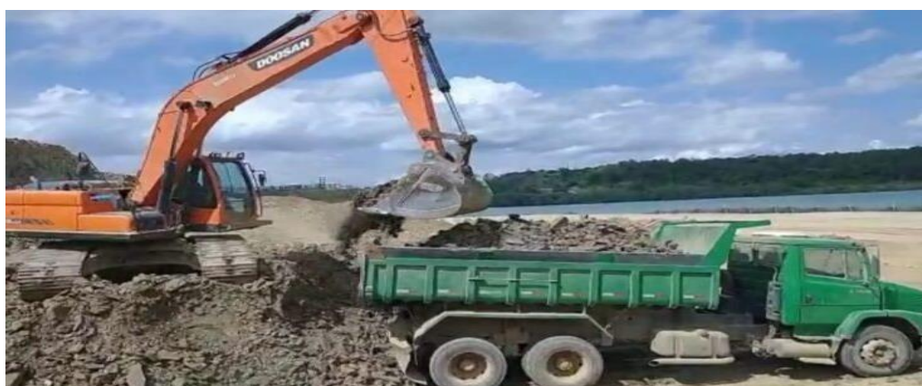
Figura 7. Pescadoras de Ilha de Maré denunciam construção portuária na localidade mesmo após decisão judicial suspendendo a obra, 2021
