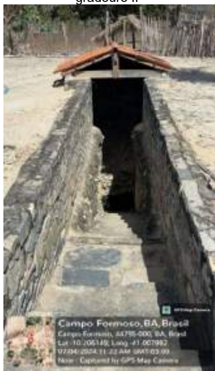
Figura 39 — Poço Aberto em Sangradouro II
