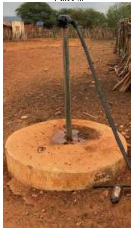
Figura 63 — Detalhe do chafariz de Patos III
