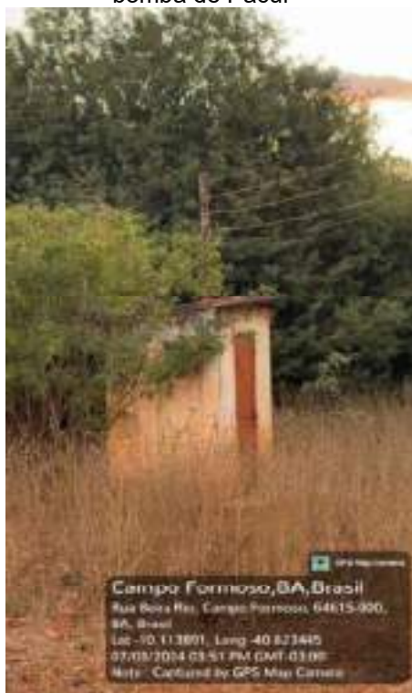
Figura 24 — Casa de Máquina da bomba de Pacuí
