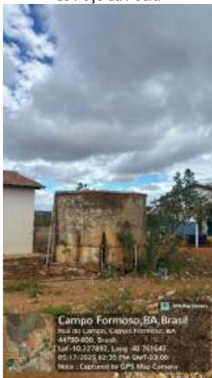
Figura 92 — Reservatório apoiado de Poço da Pedra
