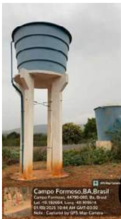
Figura 59 — Reservatório elevado de Patos II
