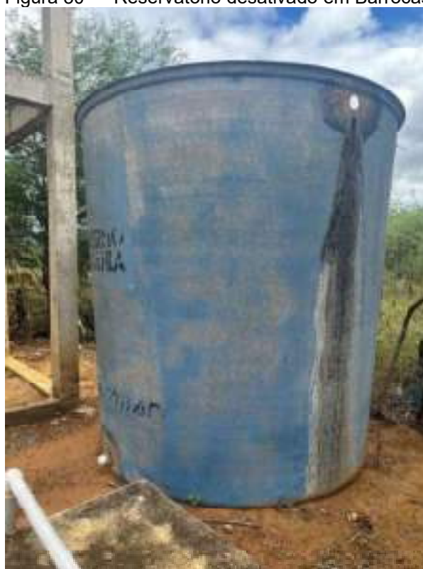
Figura 30 — Reservatório desativado em Barrocas
