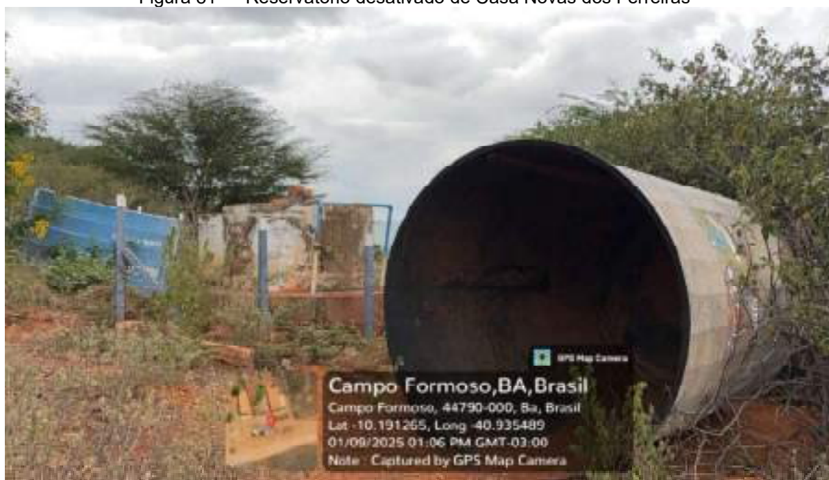
Figura 81 — Reservatório desativado de Casa Novas dos Ferreiras
