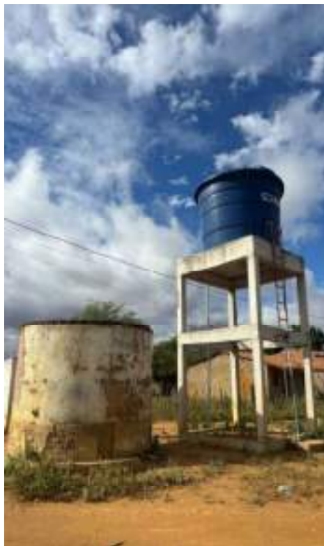
Figura 97 — Reservatórios apoiado e elevado de Saquinho
