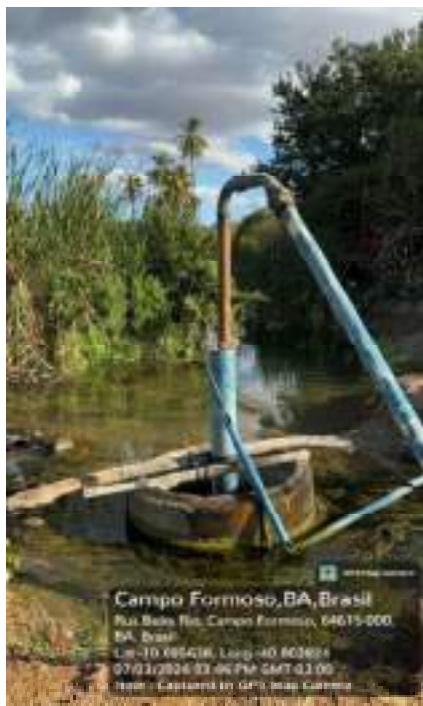
Figura 16 — Ponto de Captação em Bebedouro
