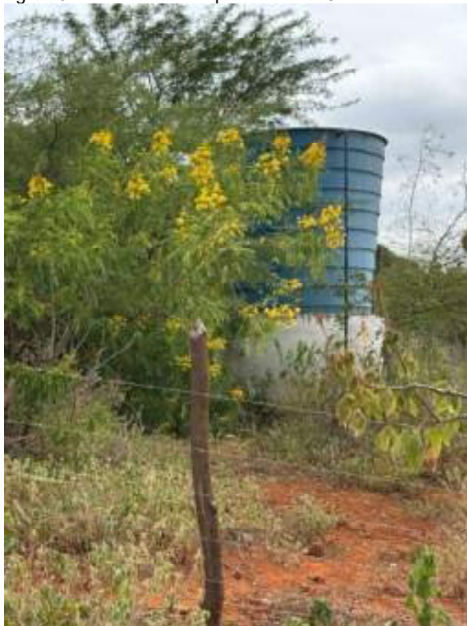
Figura 82 — Reservatório provisório da C. N. dos Ferreiras
