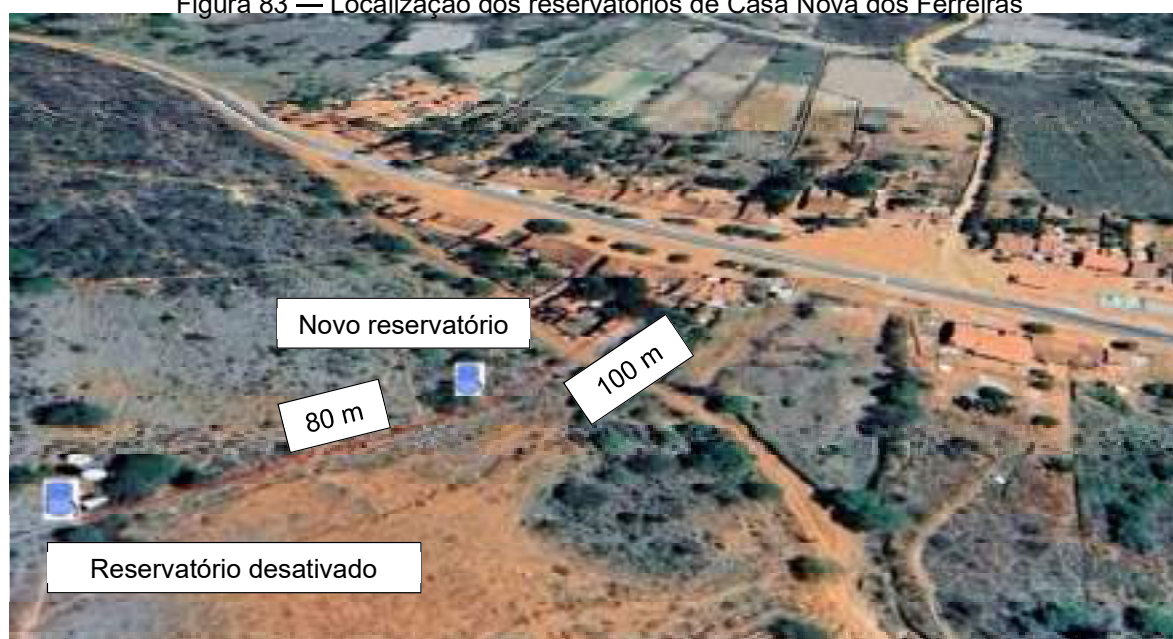
Figura 83 — Localização dos reservatórios de Casa Nova dos Ferreiras
