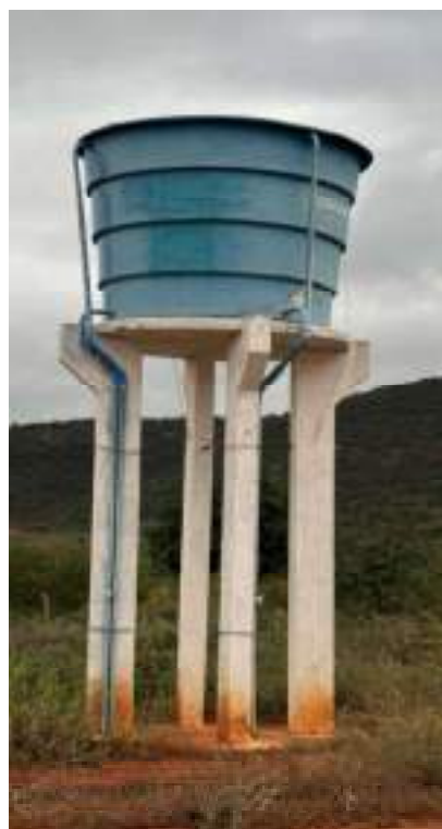
Figura 87 — Reservatório Elevado de C. N. dos Amaros
