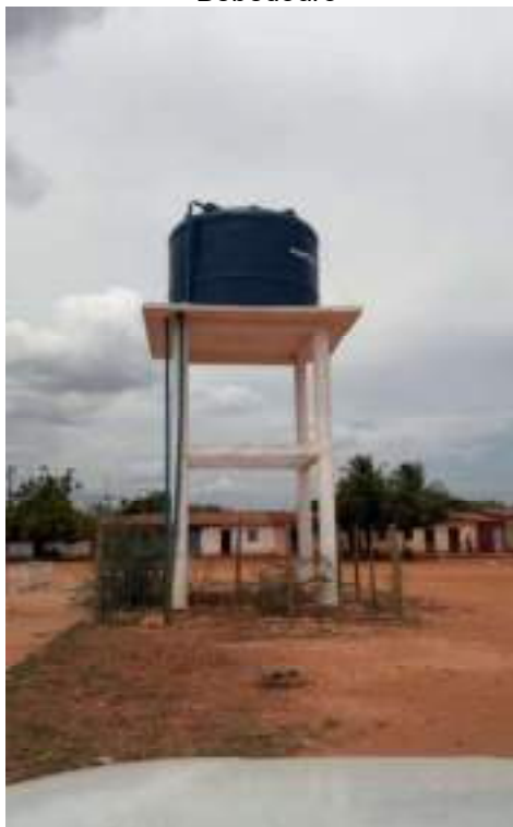
Figura 20 — Reservatório elevado em Bebedouro
