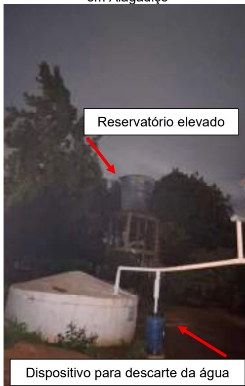
Figura 80 — Reservatório de distribuição em Alagadiço
