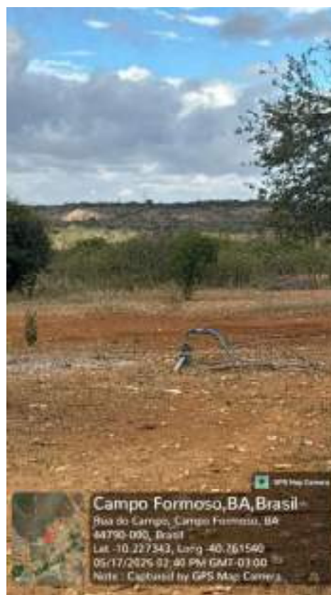
Figura 95 — EEA de Poço da Pedra
