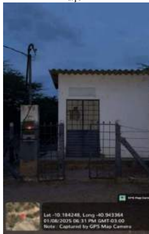
Figura 78 — Casa de bomba de Alagadiço
