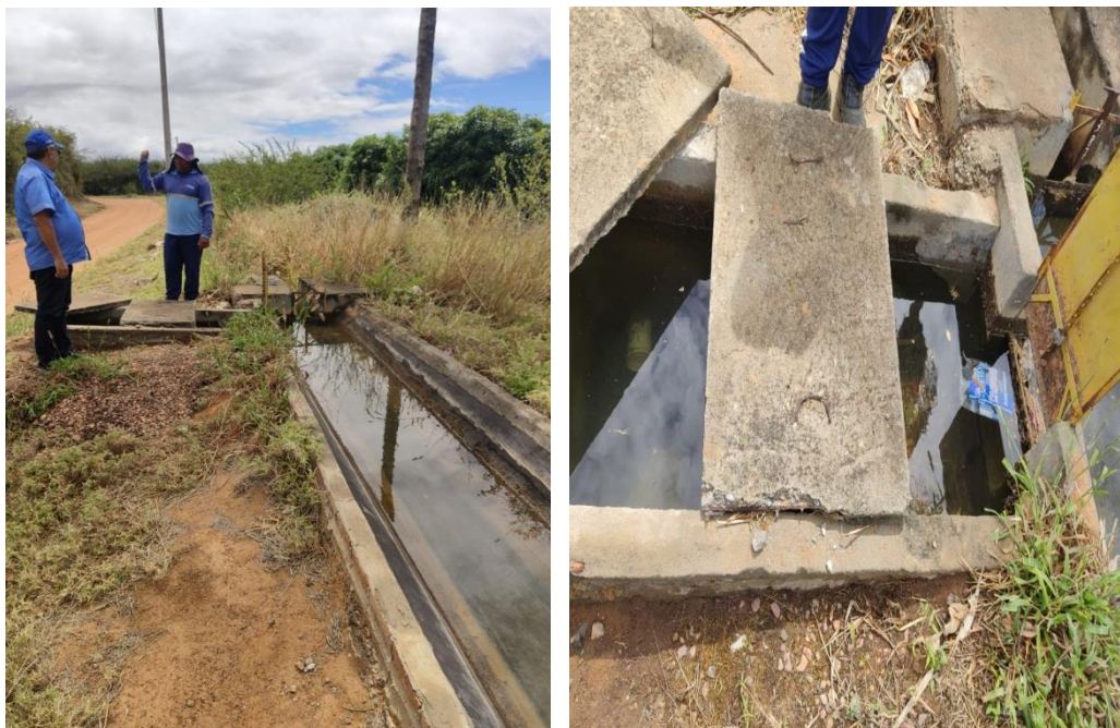
Figuras 13 - Ponto de captação de água bruta no NH4
