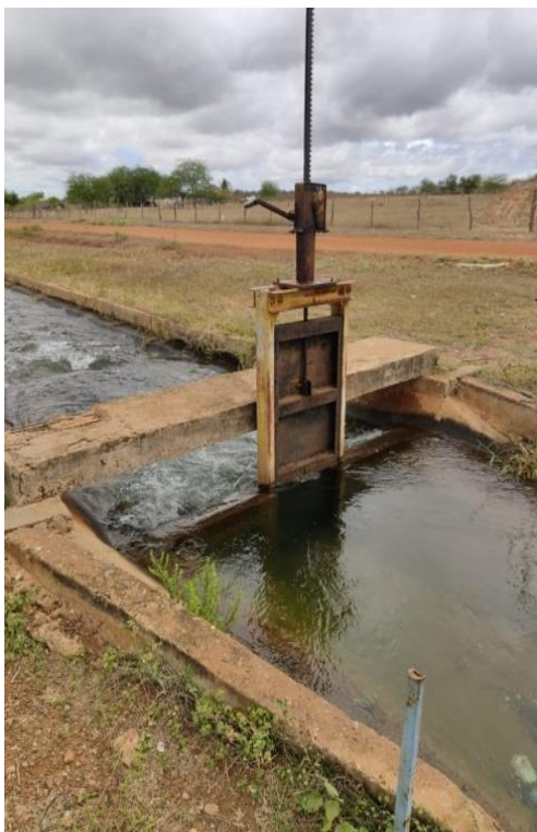
Figura 12 - Ponto de captação de água bruta no NH1
