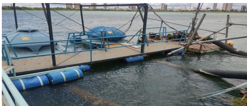
Figura 5 - Captação de água bruta no Rio São Francisco na Sede de Juazeiro (Sd).
