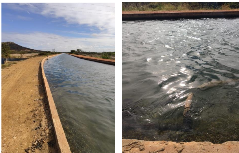
Figuras 8 - Captação de água bruta no Jardim Primavera (JP)
