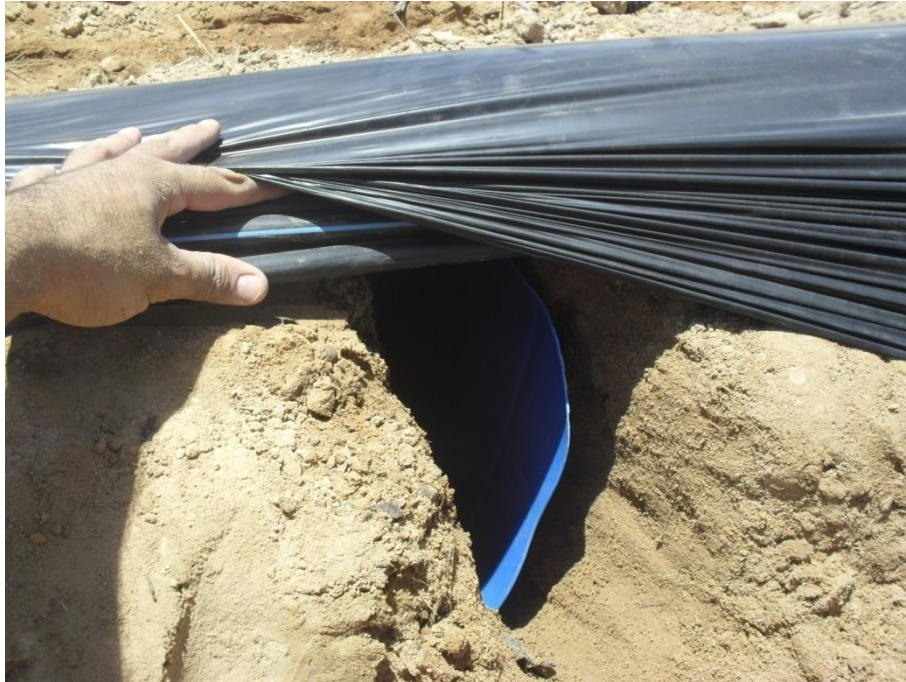
Figura 4. Preparação da instalação da barreira de plástico entre cada subparcela.
