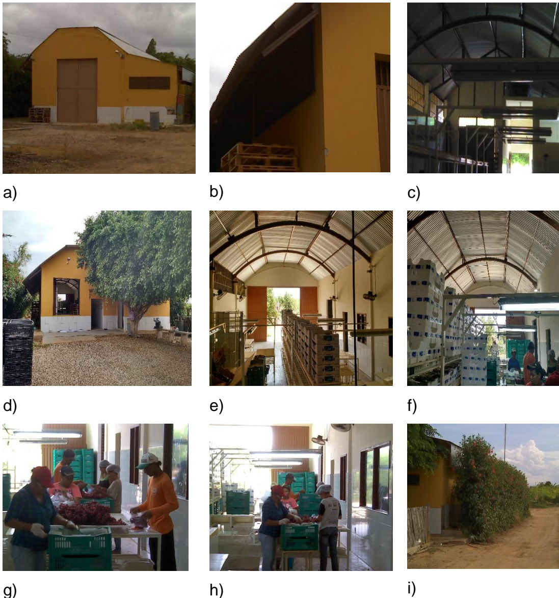
Figura 4- (a) Portão de recepção das uvas (b) Beiral com 1,8 m lado direito (c) Interior do packing (d) Desembarque para recebimento dos caminhões (e) Vista superior do galpão e posicionamento dos ventiladores (f) Caixaria nas mesas (g) Funcionários fazendo o seleção da uva (h) Posicionamento das lâmpadas e ventiladores (i) Beiral do lado esquerdo com 0,6 m e cerca viva
