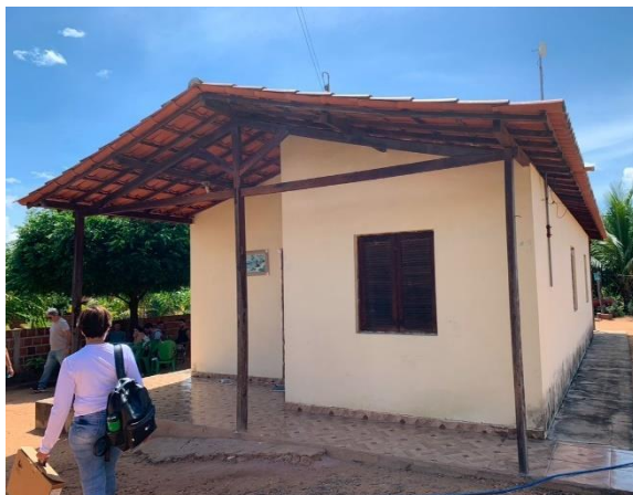
Figura 11 – Habitação padrão tipo 1 das VPR do PISF.
