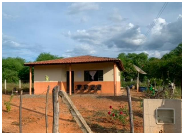
Figura 12 – Habitação padrão tipo 2 das VPR do PISF.
