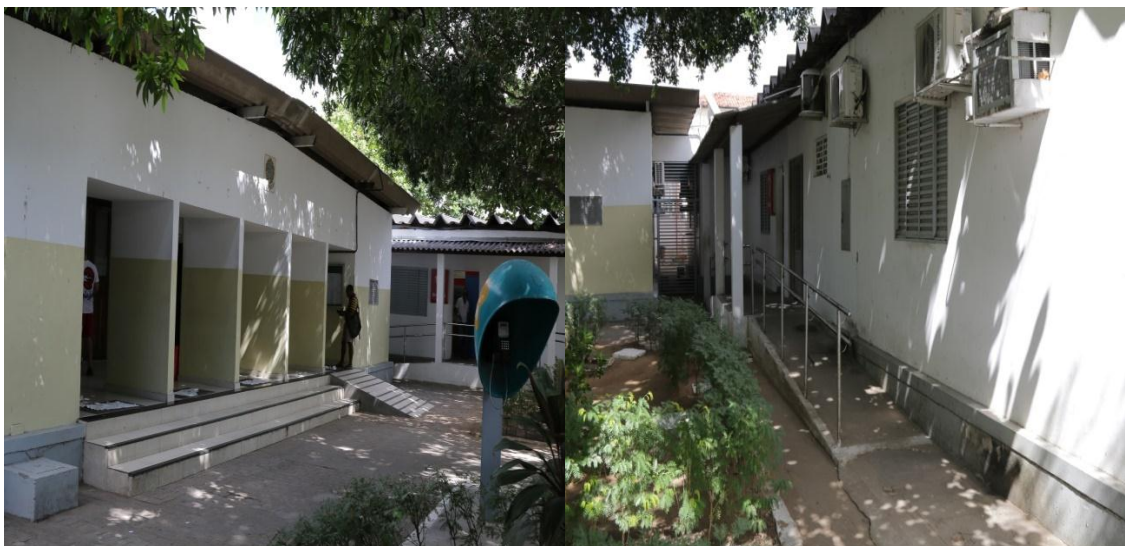
Figura 25 - Rampas externas de acessibilidade na Prefeitura
