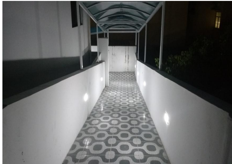
Figura 28 - Rampa interna de acessibilidade na Câmara de Vereadores
