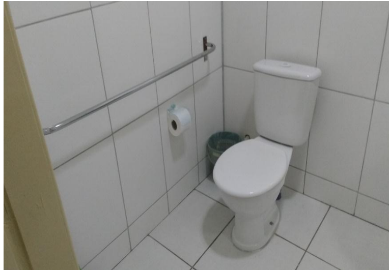
Figura 29 - Barra lateral de acessibilidade no banheiro da Câmara de Vereadores
