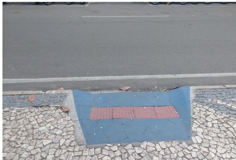
Figura 18 – Rampa de acessibilidade na Av. Getúlio Vargas
