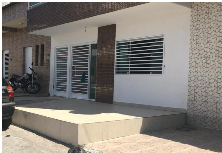
Figura 12 - Desnível entre calçadas na Rua São João
