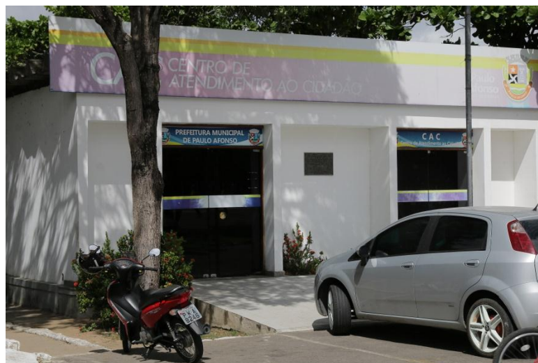
Figura 27 - Rampa de acessibilidade obstruída na Prefeitura
