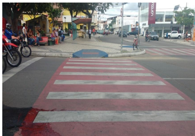
Figura 19 - Faixa de pedestre com rampa na Av. Getúlio Vargas
