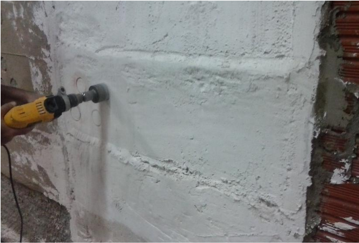
Figura 1 - Corte do revestimento para ensaio de resistência de aderência à tração
